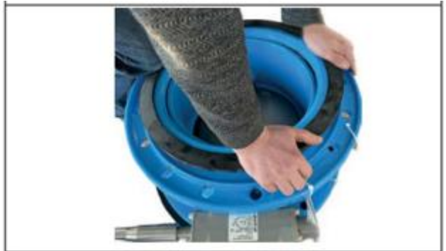
DN 350 Zwischenring mit Flanschdichtung wieder montieren
