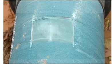
2. Montare il collare di presa come descritto al punto 5.2 e sigillare / proteggere i punti di giunzione, l'anima visibile del tubo con il sigillante n. 8349. Successivamente stendere il sigillante in modo uniforme.
