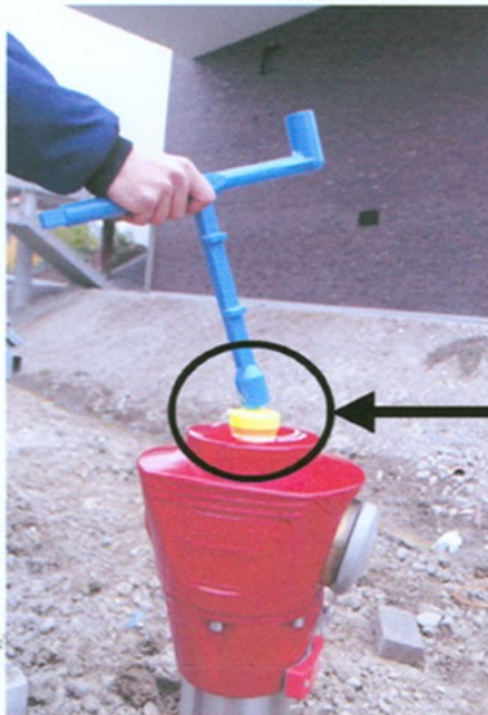
Rompere il piombo con la chiave idrante
