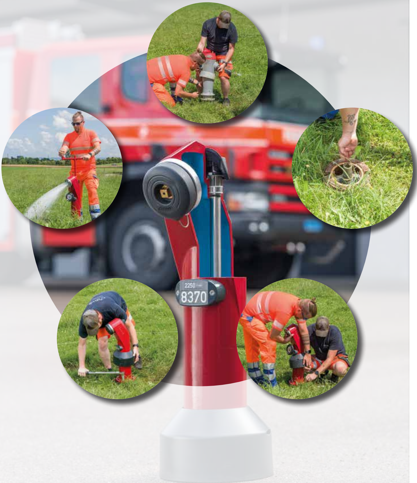
Sostituzione della parte superiore dell'idrante
