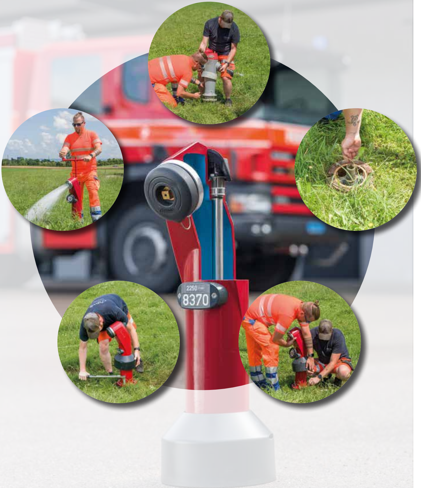
Hydranten-Oberteil-Auswechslung
