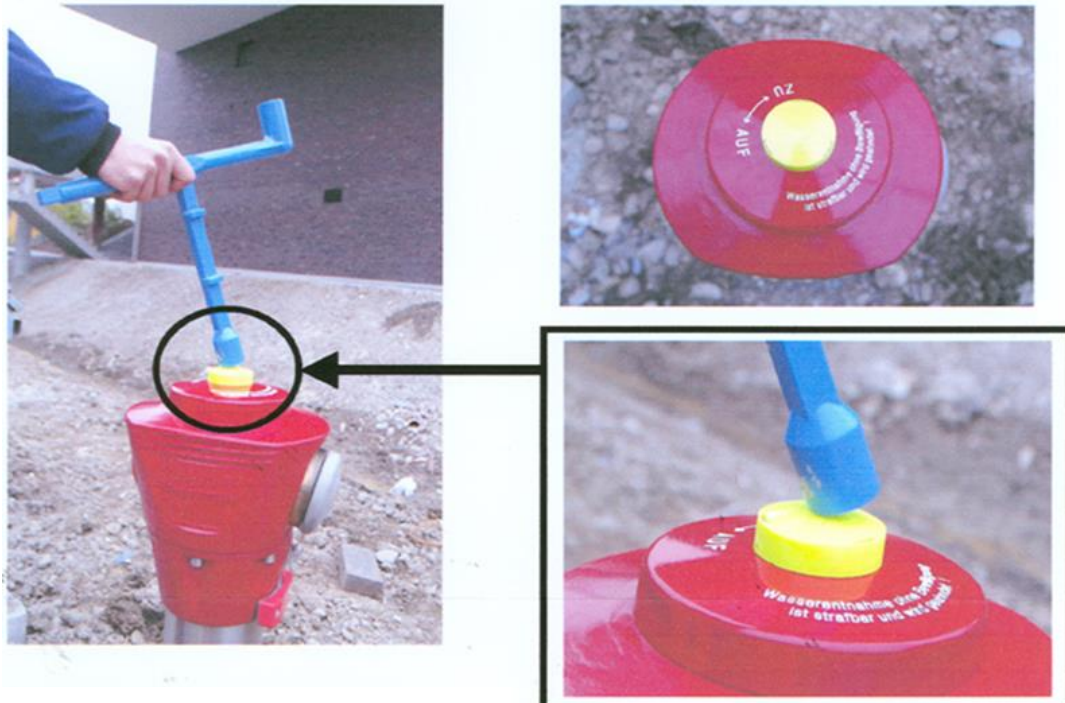
Rompere il piombo con la chiave idrante
