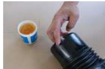
Enduire le joint à lèvres et l'O-Ring dans le manchon de lubrifiant Hawle.
