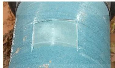
2. Montare il collare di presa come descritto al punto 5.2 e sigillare / proteggere i punti di giunzione, l'anima visibile del tubo con il sigillante n. 8349. Successivamente stendere il sigillante in modo uniforme.
