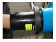
Serrer l'embout PE à souder jusqu'à la butée.
