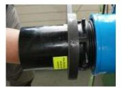
Un tour plus tard, réaliser encore une fois un contrôle. (Siège correct de l'O-Ring)
