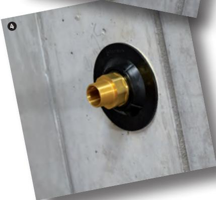
**4** Je nach Umgebungstemperatur beträgt die Aushärtungszeit des «Beto Fix» ca. 15 Minuten. Danach kann die Ausgussvorrichtung demontiert werden. Während der Aushärtungszeit kann an der Rohrleitung weitergearbeitet werden. Die Abschlussplatte auf der Gebäude-Innenseite bleibt.
