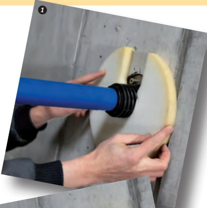
**1** Abstandhalter auf der Mauerdurchführung platzieren. Mauerdurchführung von der Gebäude-Innenseite her in die Aussparung oder Kernbohrung einführen – bis zum Anschlag der Abschlussplatte mit Dichtscheibe.
