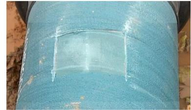
2. Anbohrschelle gemäss Pt 5.2 montieren und Schnittstellen, sichtbarer Rohrkern mit Dichtmasse Nr. 8349000100 abdichten / schützen. Dichtmasse abschliessend sauber verstreichen.
