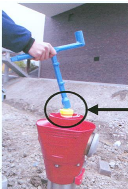
Rompere il piombo con la chiave idrante
