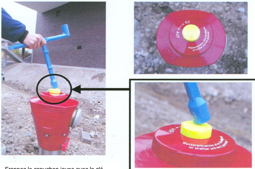
Frappez le capuchon jaune avec la clé d'hydrante
