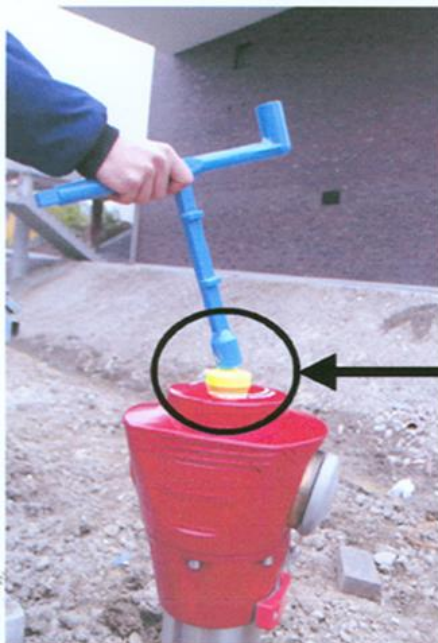
Einschlagen der Plombe mit dem Hydranten Schlüssel
