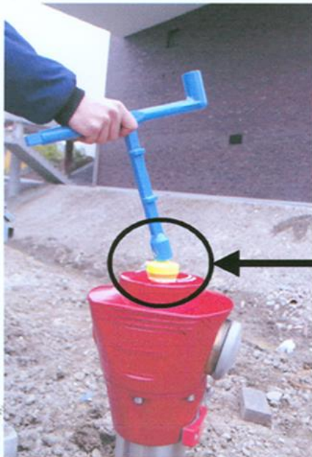
Rompere il piombo con la chiave idrante
