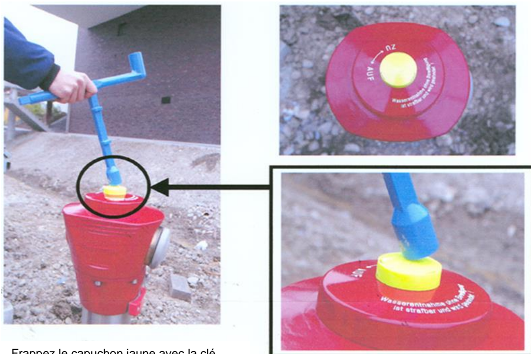
Frappes le capuchon jaune avec la clé d'hydrante
