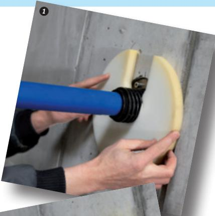
**1** Applicare il distanziale sul passaggio di muro. Inserire il passaggio di muro dal lato interno dell'edificio nell'incavo o carotaggio fino alla battuta della piastra di chiusura con anello di tenuta.
