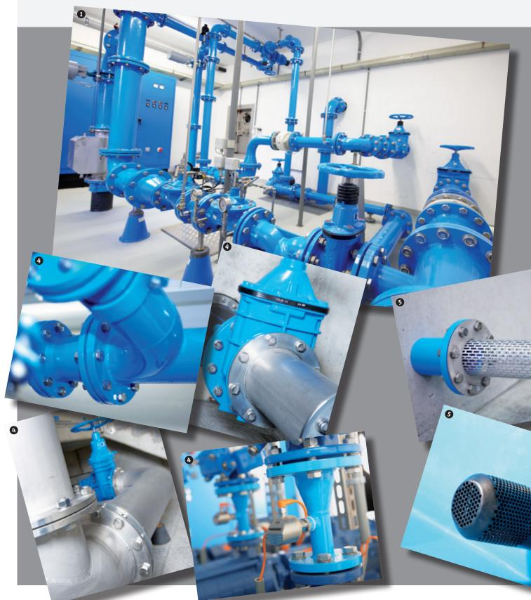
Les pièces en acier sont revêtues par pulvérisation au standard de qualité éprouvé Hawle, ce qui leur procure une protection optimale contre la corrosion.
