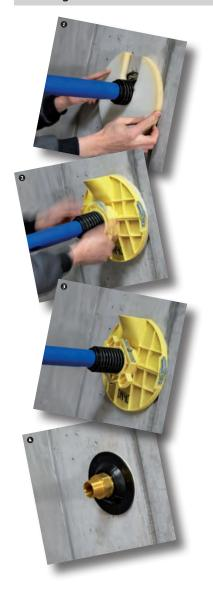
1 Placer l'entretoise sur le passage de mur. Introduire le passage de mur dans l'ouverture ou le forage depuis l'intérieur du bâtiment, jusqu'en butée de la plaque d'obturation avec le disque d'étanchéité.
