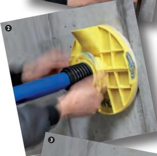
**2** Ausgussvorrichtung mit der dazu passenden Dichtscheibe an der Mauerdurchführung fixieren und den Klemmverschluss befestigen.
