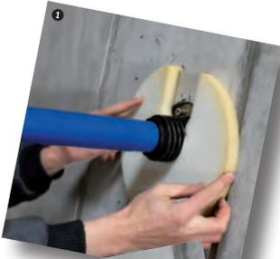
**1** Abstandhalter auf der Mauerdurchführung platzieren. Mauerdurchführung von der Gebäude-Innenseite her in die Aussparung oder Kernbohrung einführen – bis zum Anschlag der Abschlussplatte mit Dichtscheibe.
