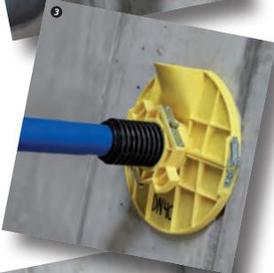
**3** Mauerdurchführung ausrichten und mit dem Klemmverschluss der Ausgussvorrichtung fest gegen das Mauerwerk verspannen. Aussparung oder Kernbohrung mit «Beto Fix» ausgießen.
