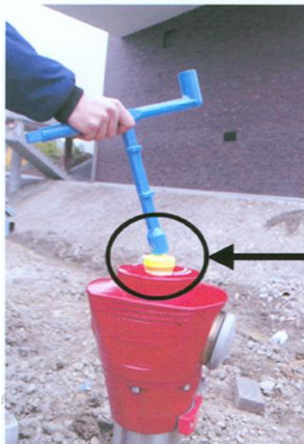
Einschlagen der Plombe mit dem Hydranten Schlüssel
